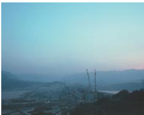
長江のせき止め工事の現場
